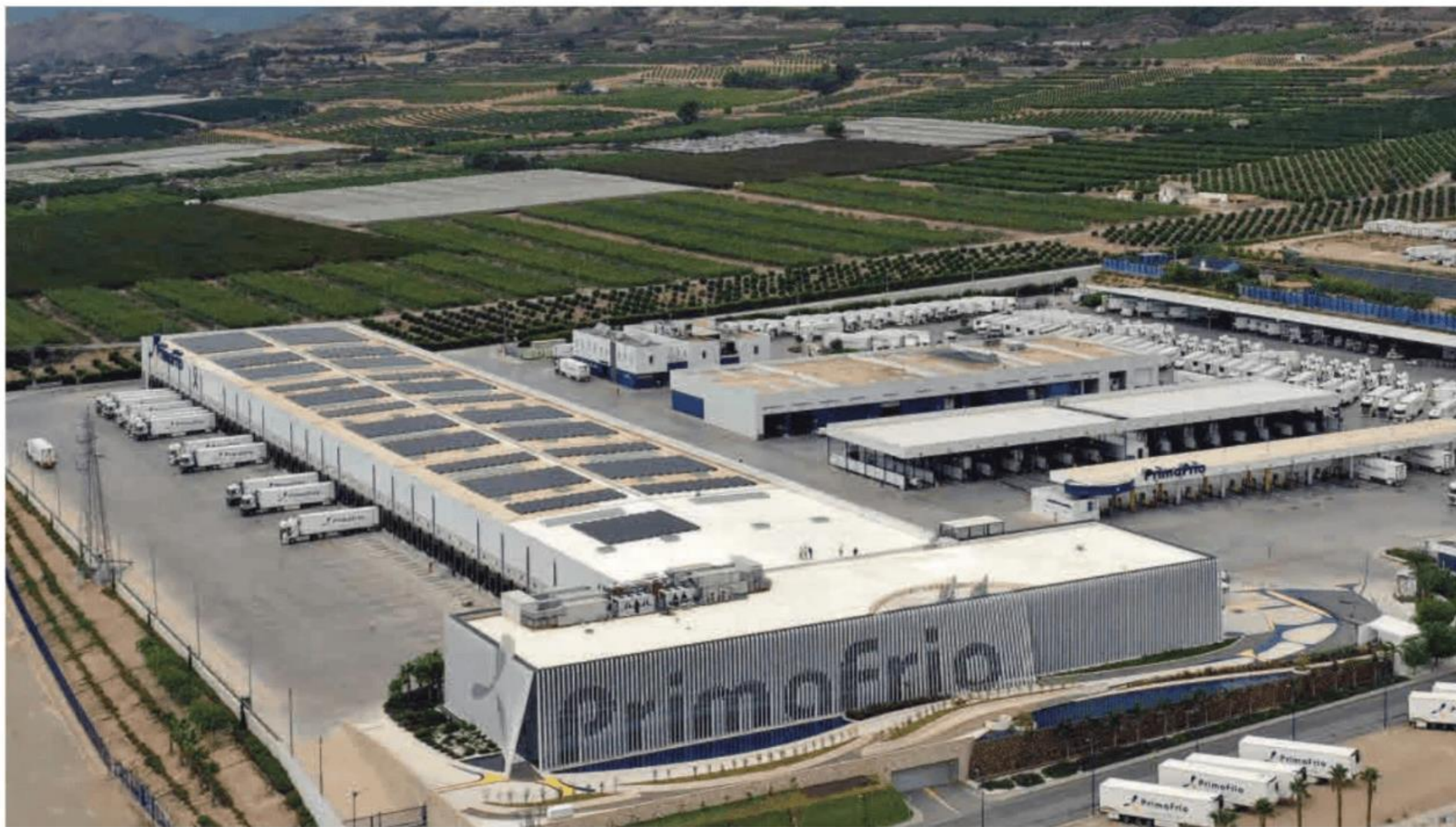
Vista general de la sede central de Grupo Primafrio en Alhama de Murcia.
